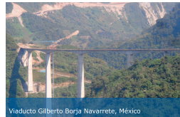
Viaducto Gilberto Borja Navarrete, México
