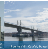
Puente Vidin Calafati, Bulgaria
